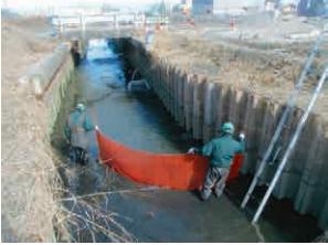
水路工事における生態調査状況
